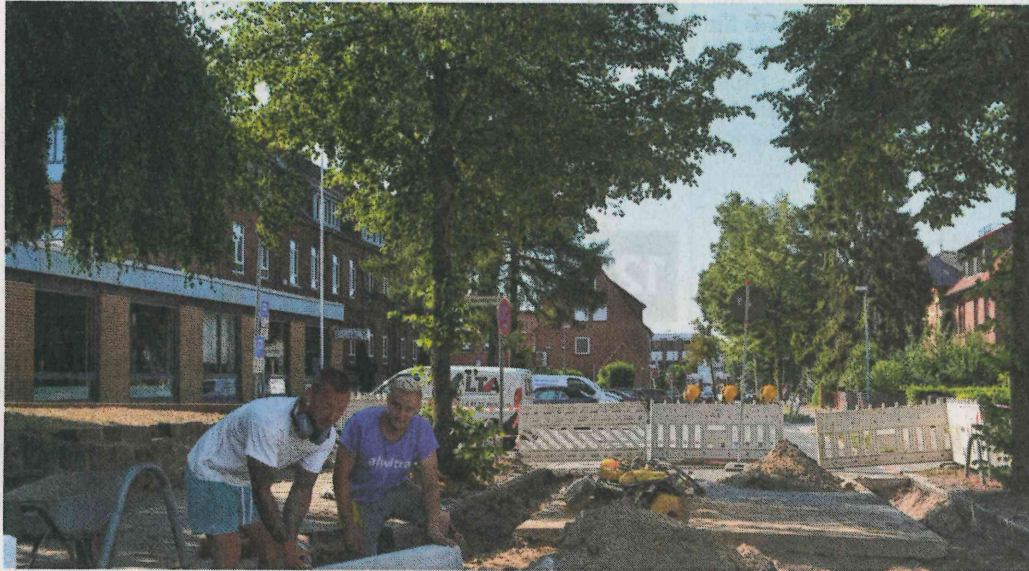
Justin Zehlik und Robert Post von der Tiefbaufirma LTA aus Lauenburg arbeiten an der Fahrbahnverengung im Weingarten.
